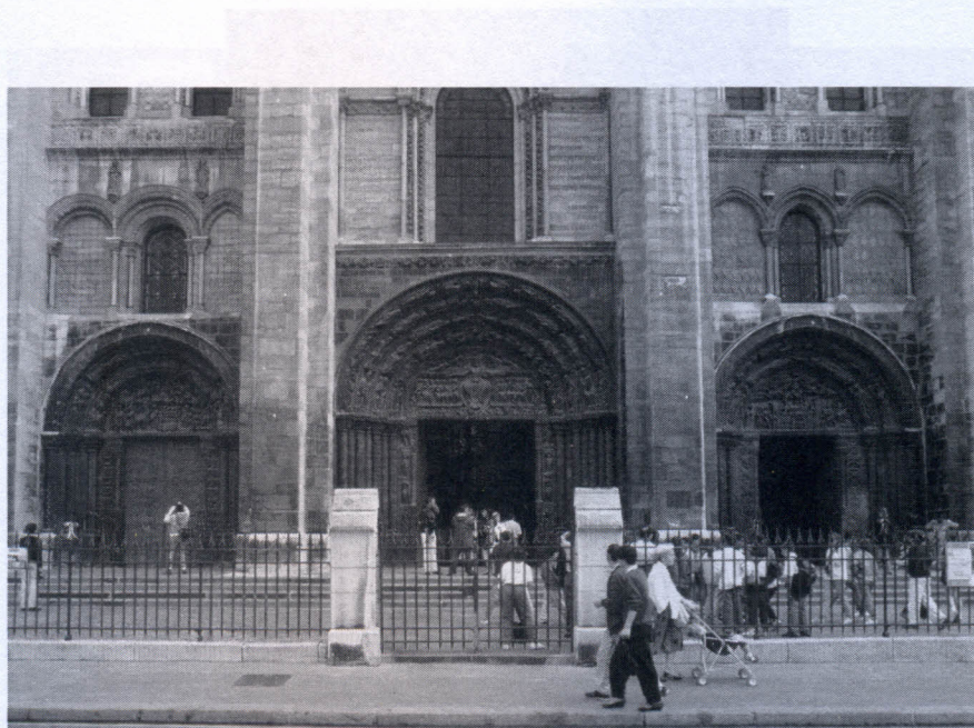
Ilustración 55. Portales de la fachada de la iglesia de Saint Denis, ca. 1135-1144. Francia.
