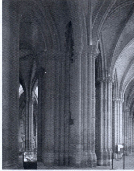
Ilustración 52. Pilares compuestos del interior del nártex, pasillo sur, hacia el noreste.
